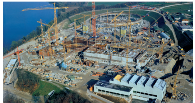
Baustelle des Kernkraftwerks Leibstadt 1977. Nach einer neuen Studie könnte ein neues Atomkraftwerk der Schweizer Wirtschaft jährlich CHF 1,6 Mrd. einbringen und rund 3000 Arbeitsplätze schaffen. (Foto: ETH-Bibliothek Zürich, Fotograf: Vogt, Jules)
