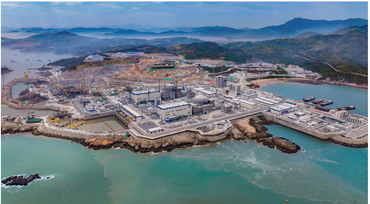
Am Standort Sanao, an der Ostküste Chinas, sollen insgesamt sechs Druckwassereinheiten des Typs Hualong One (HPR1000) gebaut werden. Sanao-1 hat bereits im April 2026 den kommerziellen Betrieb aufgenommen. Bei Sanao-2 wurde der erste Beton im Dezember 2021 gegossen und soll der Betriebsbeginn 2027 erfolgen. (Foto: CGN via www.sasac.gov.cn )
