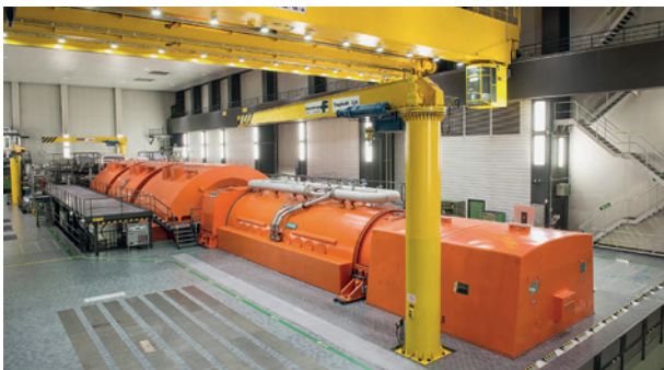
Das Maschinenhaus des Kernkraftwerks Gösgen. (Foto: KKG)
