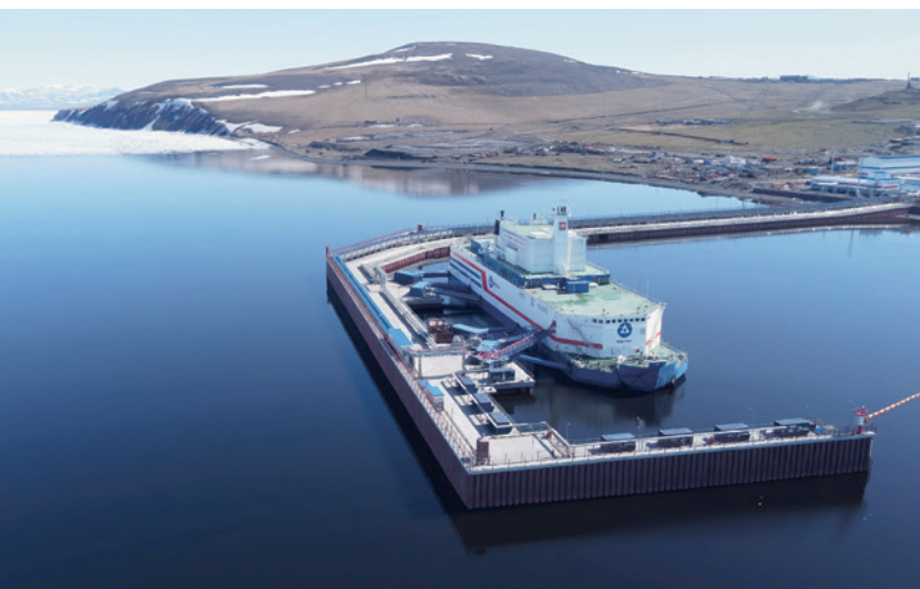
Das schwimmende Kernkraftwerk Akademik Lomonossow produziert zuverlässig Strom und Wärme mit zwei Reaktorblöcken, die von Atomeisbrechern abstammen. Nach einem Betriebszyklus von bis zu 3,5 Jahren wird jeweils der gesamte Reaktorkern mit frischem Brennstoff neu beladen. Erstmals erfolgte dies Ende 2023 respektive Ende 2024. (Foto: Tass via Atom Media)
