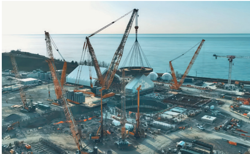
Am kanadischen Kernkraftwerksstandort Darlington läuft der Bau des SMR BWRX-300. Es ist der erste Neubau eines Kernkraftwerks in Kanada seit über 30 Jahren und der erste SMR der Generation III+, der in den G7-Staaten gebaut wird. Der Screenshot zeigt das Einbringen der vormontierten Fundamentplatte in den Schacht des Reaktorgebäudes. (Foto: Screenshot aus YouTube-Video von OPG)
