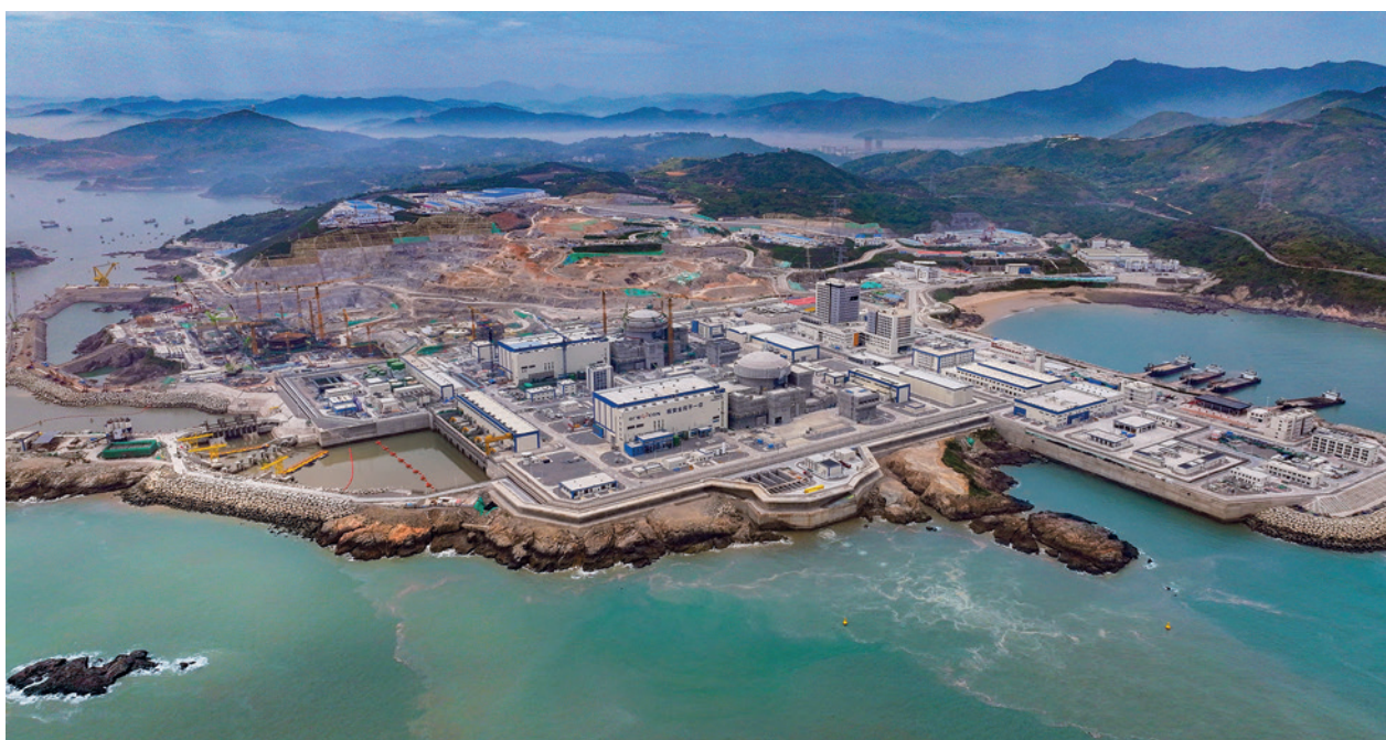
Sur le site de Sanao (côte est de la Chine), il est prévu de construire en tout six réacteurs à eau sous pression du type Hualong One (HPR1000). Sanao 1 a été mis en service commercial en avril 2026 déjà. Quant à Sanao 2, dont le premier béton a été coulé en décembre 2021, sa mise en service devrait intervenir en 2027. (Photo: CGN via www.sasac.gov.cn )
