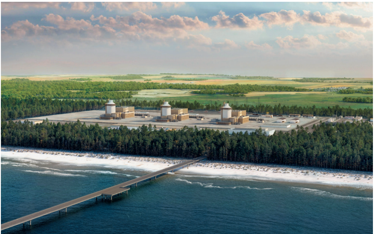
Représentation du premier projet de centrale nucléaire en Pologne, à Lubiatowo-Kopalino. (Photo: PEJ)
