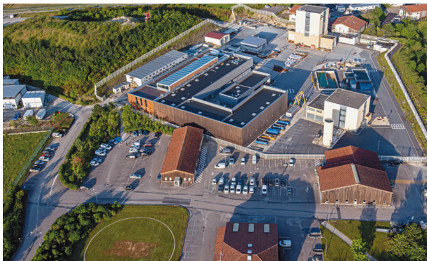
Vue aérienne des installations de surface du laboratoire souterrain de Bure. C'est là, dans le sous-sol, que l'Andra mène depuis 25 ans des expérimentations et des essais technologiques dans un environnement représentatif du futur centre de stockage géologique. (Photo: Andra)
