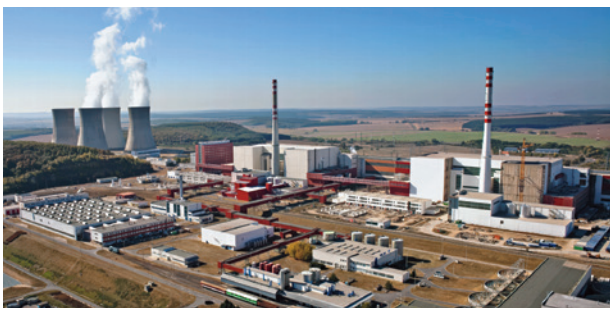
Le site de la centrale nucléaire de Mochovce est une des options pour déployer des SMR en Slovaquie. (Photo: Slovenské elektrárne)
