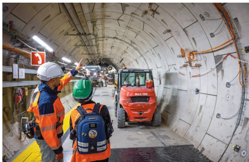
Einer der Versuchsstollen im unterirdischen Felslabor, in dem die wesentlichen Prozesse der geologischen Tiefenlagerung unter realistischen Bedingungen erforscht werden. (Foto: Andra)
