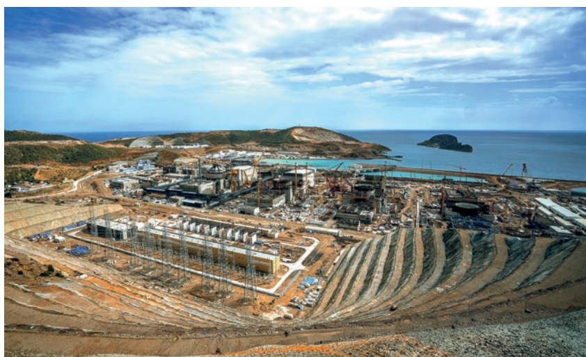
En construction dans le sud de la Turquie, sur la côte méditerranéenne, dans la province de Mersin, la centrale nucléaire d'Akkuyu comprendra quatre réacteurs à eau sous pression du type russe VVER-1200 de Rosatom. Le premier d'entre eux devrait être mis en service d'ici juin 2026. Rosatom mettra en service deux tranches du même type au Kazakhstan, sur le site d'Ulken. (Photo: Akkuyu Nuclear)
