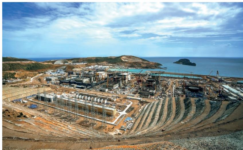
Das Kernkraftwerk Akkuyu wird im Süden der Türkei, in der Provinz Mersin an der Mittelmeerküste gebaut. Es besteht aus vier Druckwasserreaktoren des russischen Typs WWER-1200 von Rosatom. Der erste davon soll spätestens im Juni 2026 den Betrieb aufnehmen. Zwei solche Einheiten wird Rosatom auch beim ersten grossen Kernkraftwerk in Kasachstan am Standort Ulken einsetzen. (Foto: Akkuyu Nuclear)
