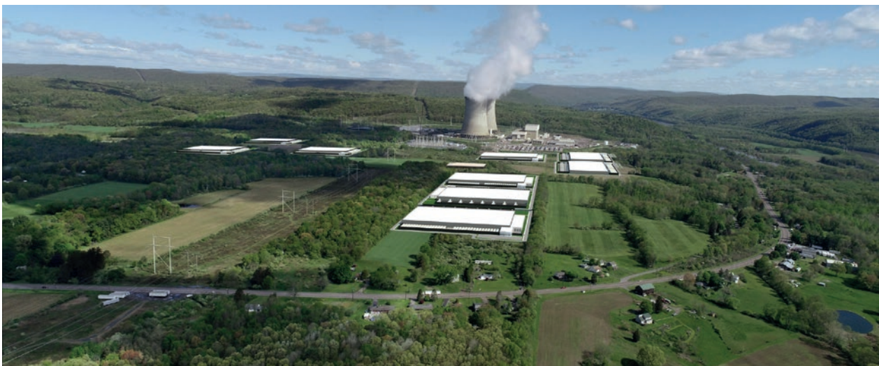
AWS a acheté à Talen Energy le campus de centre de calcul «Cumulus», qui est directement connecté à la centrale nucléaire de Susquehanna. (Photo: Linxon)
