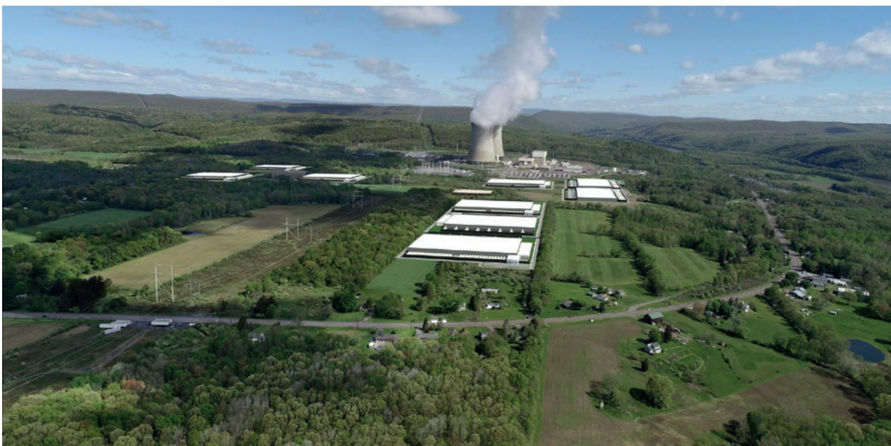
AWS kaufte von Talen Energy das Rechenzentrum «Cumulus», das direkt an das Kernkraftwerk Susquehanna angeschlossen ist. (Foto: Linxon)
