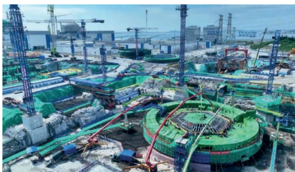
Giessen des ersten sicherheitsrelevanten Betons bei der Hualong-One-Einheit Zhangzhou-4. (Foto: Screenshot aus Video von cnnpn.cn, Kernkraftwerk Zhangzhou)
