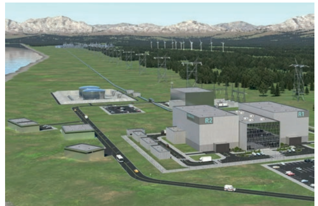
Ansicht eines Kernkraftwerks von Terrestrial Energy bestehend aus zwei Flüssigsalzreaktoren IMSR400 mit einer thermischen Leistung von je 400 MW. (Foto: Terrestrial Energy)
