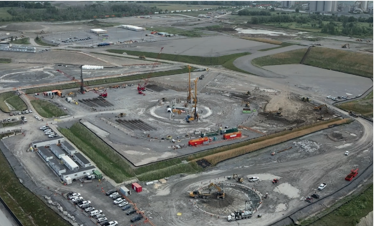
Fortschritt bei den nicht nuklearen Bauarbeiten im Darlington New Nuclear Project mit Stand Juli 2024: Nach dem Erstellen der Stützmauer des Startschachts der Tunnelbohrmaschine (unterer Bildrand) wird die Stützwand für den Aushub des ersten Reaktor Gebäudes (Bildmitte) gebohrt. Die Tunnelbohrmaschine dient dem Erstellen des Tunnels für die Zuleitung des Kühlwassers aus dem Ontariosee.» (Foto: OPG via YouTube)
