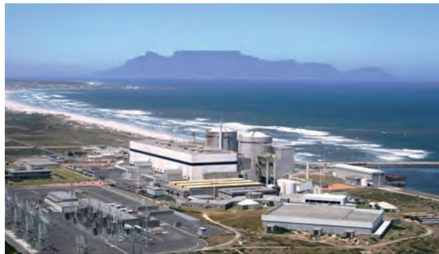
La centrale nucléaire sud-africaine de Koeberg avec ses deux réacteurs à eau sous pression de 900 MW se trouve à 30 kilomètres au nord du Cap. (Photo: Eskom)
