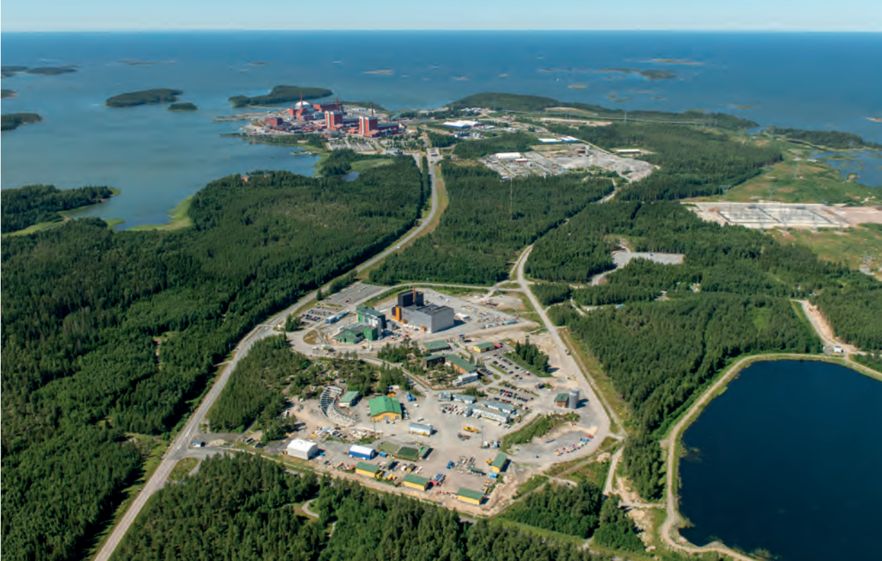
Auf der finnischen Halbinsel Olkiluoto befinden sich das Kernkraftwerk Olkiluoto mit seinen drei Blöcken (Hintergrund) und die Verpackungsanlage (schwarzes Gebäude im Vordergrund) sowie der Zugang zum Tiefenlager, die als Rampe beim grossen grünen Gebäude erkennbar ist. (Foto: TVO)
