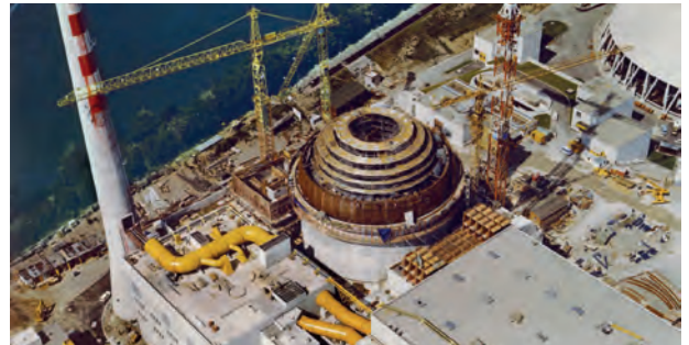
1981: Blick von Süden – Das Reaktorgebäude ist noch in Bau. Beim Kran handelt es sich um einen Kaiser HBK 150.1. (Foto: KKL)
