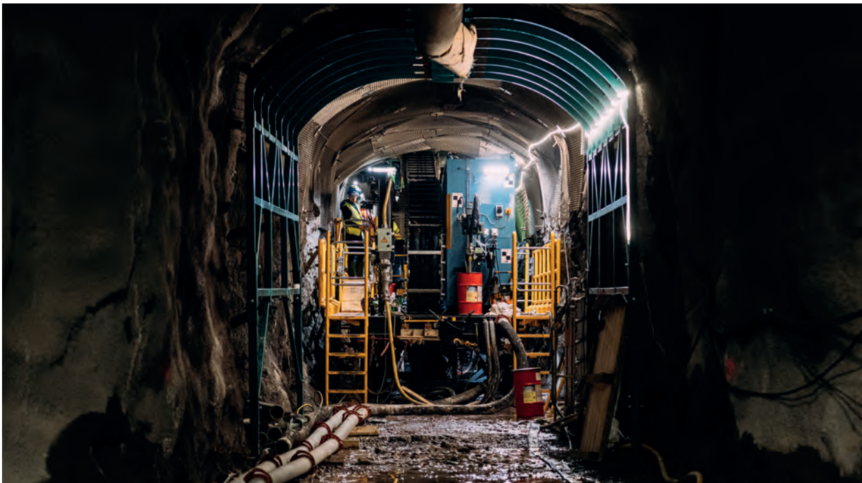
In einer Tiefe von rund 450 Metern unter dem Erdboden werden im Tiefenlager «Onkalo» die vertikalen Einlagerungslöcher erstellt. Sie nehmen die Endlagerbehälter aus Kupfer auf. Die Downhole Boring Machine (DHBM) der Firma Herrenknecht bohrt dazu Löcher von einem Durchmesser von 1,75 Metern und einer Tiefe von rund 8,3 Metern in das Granitgestein. (Foto: Tapani Karjanlahti / TVO)
