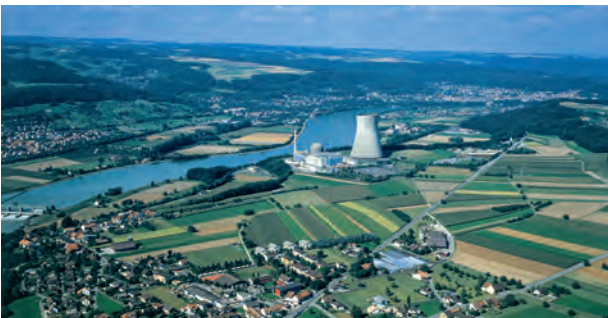
2002: Das Kernkraftwerk Leibstadt von oben (Foto: ETH-Bibliothek Zürich, Bildarchiv/Stiftung Luftbild Schweiz / Fotograf: Swissair Photo AG / LBS_L2-025534 / CC BY-SA 4.0)
