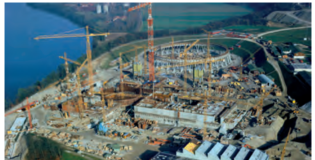
1977: Die Bauarbeiten schreiten zügig voran. (Foto: ETH-Bibliothek Zürich, Bildarchiv / Fotograf: Vogt, Jules / Com_FC27-4353-002 / CC BY-SA 4.0)
