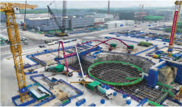
Mit dem Giessen des ersten Betons ist die chinesische Kernkraftwerkseinheit Xudabao-2 im Nordosten Chinas offiziell in Bau. (Foto: CNNC)
