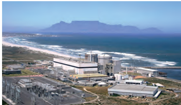
Das südafrikanische Kernkraftwerk Koeberg mit seinen zwei 900-MW-Druckwasserreaktoren liegt 30 Kilometer nördlich von Kapstadt. (Foto: Eskom)
