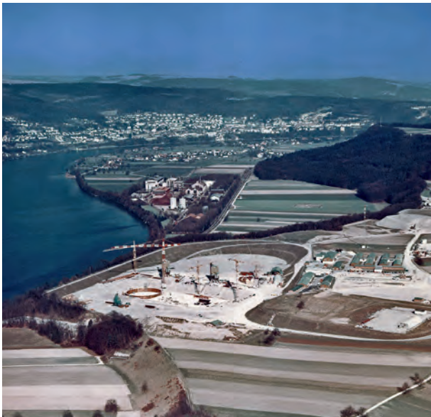
1976: Ein grosser Teil der Bauarbeiten führen regionale Auftragnehmer durch. (Foto: KKL)
