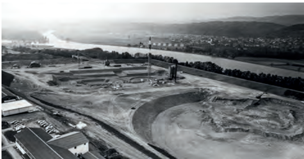
1974: Aushub für den Bau des Kernkraftwerkes Leibstadt, im Hintergrund liegt das Dorf Dogern, Deutschland. Für die schlüsselfertige Erstellung der Hauptanlagen (Reaktor und Maschinenhaus) ist ein Konsortium aus der schweizerischen Brown Boveri & Cie. (BBC) in Baden und der amerikanischen Firma General Electric (GE) verantwortlich. Die Bauleitung für Nebenanlagen wie Kühlturm, Werkstatt oder Bürogebäude werden der Elektrowatt AG übertragen. (Foto: ETH-Bibliothek Zürich, Bildarchiv / Fotograf: Albrecht, Beat / Com_M23-0045-0007-0001 / CC BY-SA 4.0)
