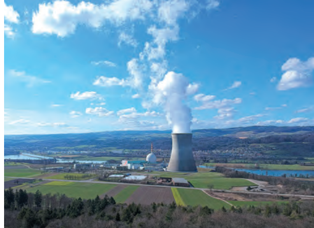
2022: Das Kernkraftwerk Leibstadt produzierte 2022 so viel Strom wie noch nie seit der Inbetriebnahme 1984. Möglich wurde dies dank der 2021 umgesetzten Erneuerungen von Kondensator und Umwälzsystem. Der Austausch des Kondensators hat bei gleichbleibender Reaktorleistung die elektrische Leistung um 10 MW auf 1285 MW erhöht. Die Erneuerungen des Umwälzsystems mit drehzahleregelten Motoren haben zudem den Eigenverbrauch der Anlage um 3 MW reduziert. (Foto: Max Brugger)
