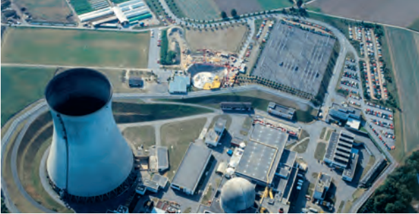
1992: In der Mitte des Fotos sieht man die Baustelle für das neue Ausbildungs- und Informationszentrum, das seither modernisiert worden ist. (Foto: ETH-Bibliothek Zürich, Bildarchiv/Stiftung Luftbild Schweiz / Fotograf: Swissair Photo AG / LBS_L1-920880 / CC BY-SA 4.0)
