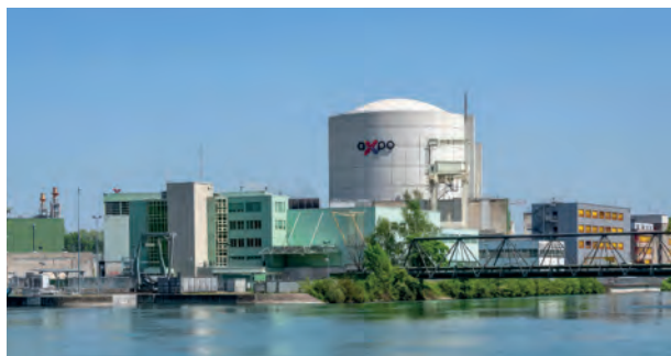
Dans le cadre d'un préprojet, Axpo étudie la possibilité de faire fonctionner la centrale nucléaire de Beznau au-delà de 60 ans. (Photo: Axpo)
