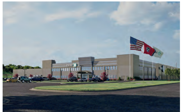
Une illustration de l'installation de fabrication de combustible Triso-X de X-energy à Oak Ridge qui sera inaugurée en 2025. (Photo: X-energy)
