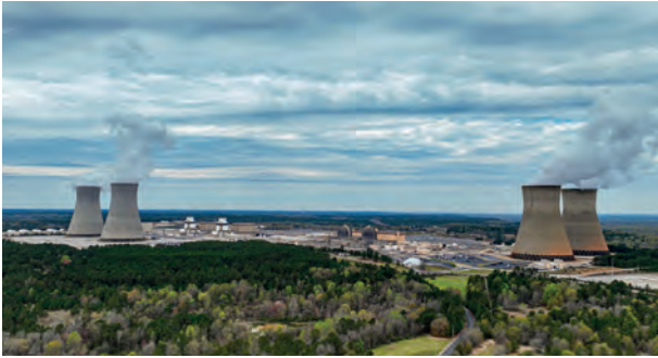
Le site nucléaire de Vogtle, dans l'État américain de Géorgie, avec ses quatre réacteurs. À gauche: les tranches 3 et 4 du type AP-1000. (Photo: Georgia Power)
