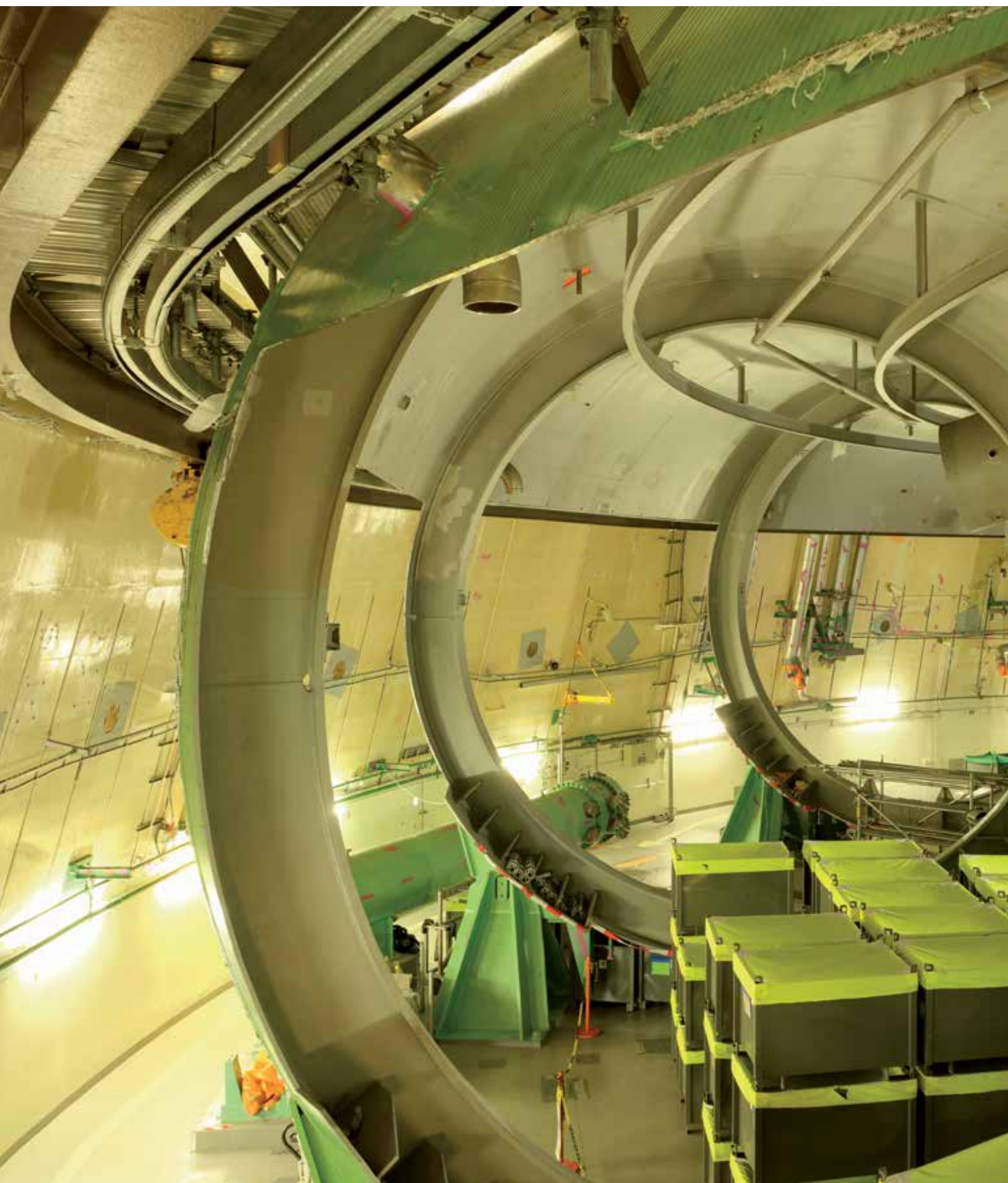
Rückbau des Kernkraftwerks Mühleberg: Die Demontage der ehemaligen Druckabbaukammer (Torus) ist weit fortgeschritten. Démantèlement de la centrale nucléaire de Mühleberg: le démontage de l'ancienne chambre de réduction de la pression (le tore) est bien avancé.
