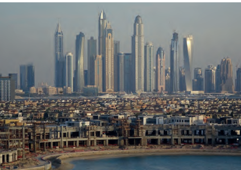
Pour faire face à la croissance fulgurante de leurs besoins en électricité, les Émirats arabes unis (ici Abu Dhabi) misent notamment sur l'énergie nucléaire. (Photo: Martin Lewison/Flickr)
