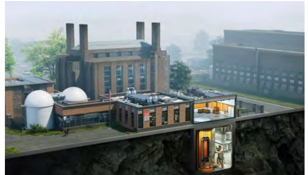
Der Micro Modular Reactor der amerikanischen Reaktorentwicklerin USNC ist ein gasgekühlter Hochtemperatur-Mikroreaktor der Generation IV. Er wird unterirdisch errichtet. (Foto: USNC)
