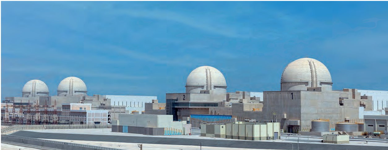
Die vier Einheiten des Kernkraftwerks Barakah wurden in einer Bauzeit von jeweils rund acht Jahren fertiggestellt. (Foto: Enec)
