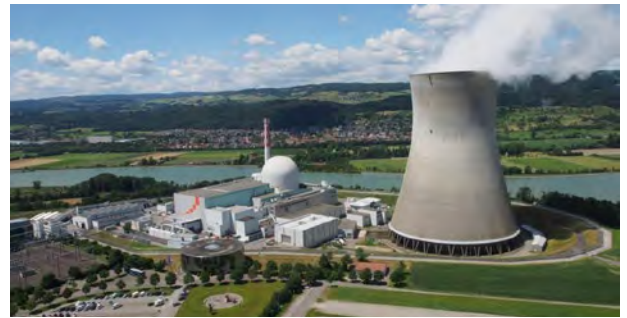
Das Kernkraftwerk erreicht erneut eine Rekord-Stromproduktion. (Foto: Kernkraftwerk Leibstadt)
