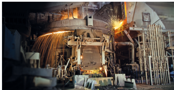
Le nouveau projet de fusion fournira du courant propre pour couvrir la charge de base de l'aciérie de Nucor. (Photo: Nucor)
