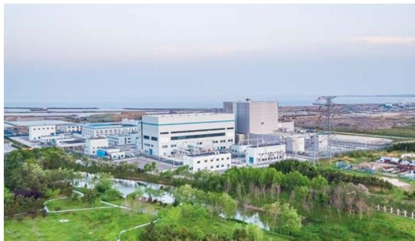
Un SMR est en service depuis fin 2021 sous forme d'installation de démonstration dans la province chinoise de Shandong. Il s'agit du «High-Temperature Gas-Cooled Reactor – Pebble Bed Module» (HTR-PM), un réacteur haute température à lit de boulets refroidi à l'hélium, composé de deux modules d'une puissance électrique de 100 MW chacun, qui entraînent une turbine à vapeur commune.
