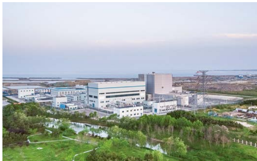
In der chinesischen Provinz Shandong steht seit Ende 2021 ein SMR als Demonstrationsanlage in Betrieb, der «High-Temperature Gas-Cooled Reactor – Pebble Bed Module» (HTR-PM). Der HTR-PM ist ein mit Helium gekühlter Kugelhaufen-Hochtemperaturreaktor, der aus zwei Modulen mit einer elektrischen Leistung von je 100 MW besteht, die eine gemeinsame Dampfturbine antreiben.
