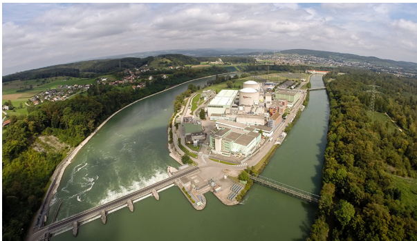
Selon l'IFSN, les installations nucléaires suisses, comme ici la centrale nucléaire de Beznau, ont été exploitées en 2022 conformément aux prescriptions légales en matière de sécurité. (Photo: Axpo)
