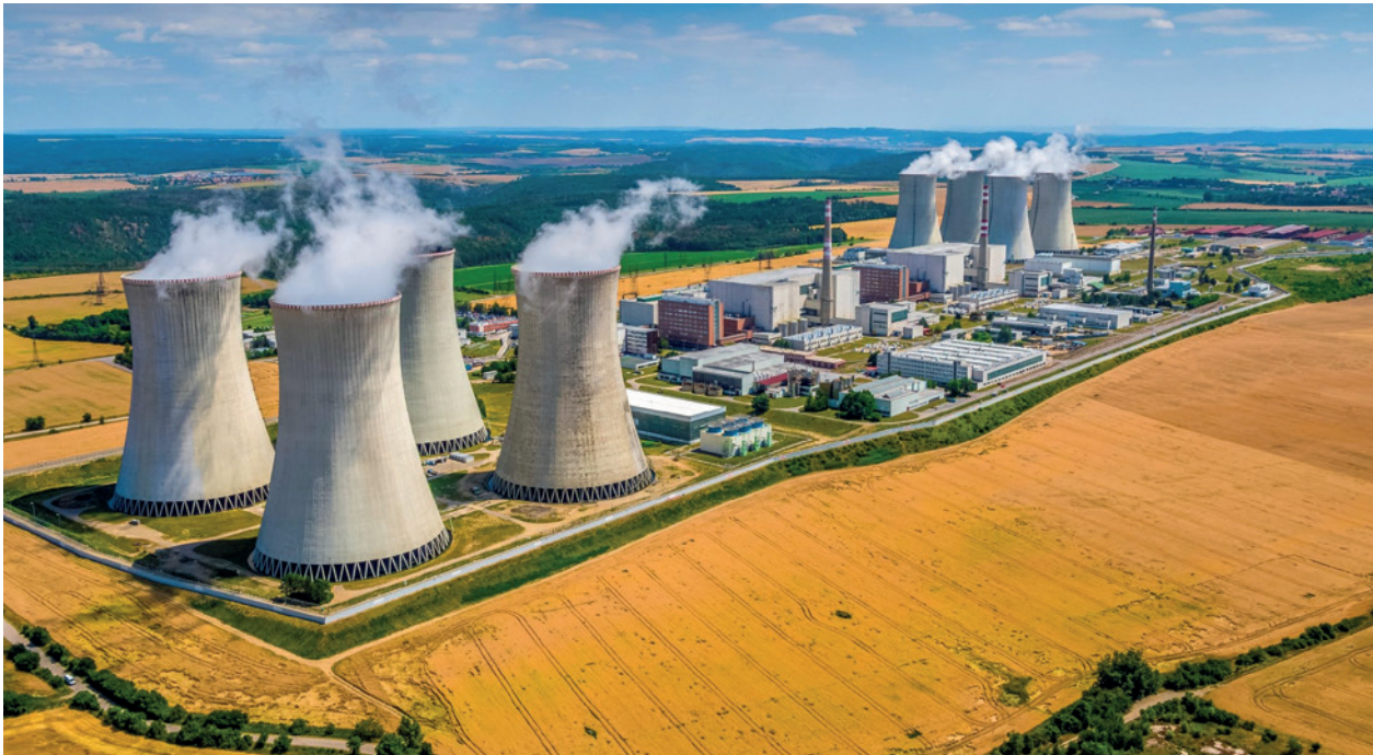
Das Kernkraftwerk Dukovany liegt im Südosten des Landes, rund 100 Kilometer von Wien entfernt. Es besteht aus vier russischen Druckwasserreaktoren des Typs WWER-440/V-213 mit einer elektrischen Leistung von je rund 470 MW. Der staatliche tschechische Energieversorger ČEZ plant dort den Bau einer fünften Kernkraftwerkseinheit und hat dafür bereits Angebote von Reaktorherstellern erhalten.
