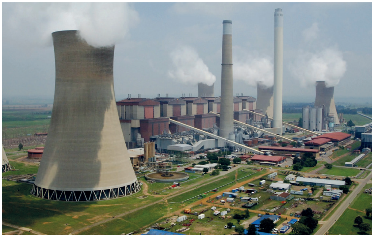
Riche en charbon, l'Afrique du Sud possède de nombreuses centrales alimentées par ce combustible, qui approvisionnent le pays en charge de base. Il s'agit notamment de la centrale de Matla (six tranches), dans la province de Mpumalanga (nord-est du pays). Elle est alimentée en charbon par sa propre mine qui, selon son exploitant (Exxaro), assure un revenu à des milliers d'employés. (Photo: Escom)
