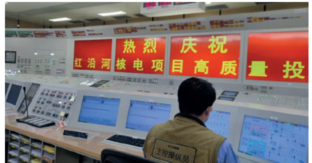
Die Kernkraftwerkseinheit Hongyanhe-6 nimmt am 23. Juni 2022 den kommerziellen Betrieb auf. (Foto: CGN)
