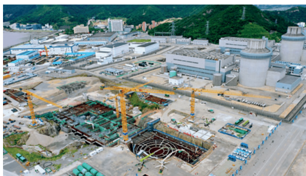
Für Block 3 des Kernkraftwerks Sanmen wird der erste Beton gegossen. (Foto: CGN) →
