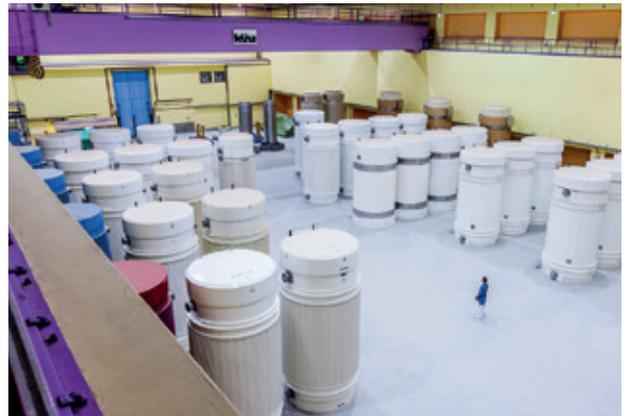
Coup d'œil dans la halle de stockage des conteneurs à Zwilag, Wurenlingen. Cette halle permet de stocker les déchets vitrifiés hautement radioactifs issus des installations de retraitement et les assemblages combustibles usés provenant des centrales nucléaires suisses. (Photo: Zwilag)
