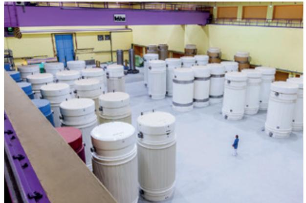
Blick in die Behälterlagerhalle des Zwiilags in Würenlingen. Sie dient der Aufnahme von verglasten, hochaktiven Abfällen aus den Wiederaufarbeitungsanlagen und von ausgedienten Brennelementen aus den schweizerischen Kernkraftwerken. (Foto: Zwiilag)
