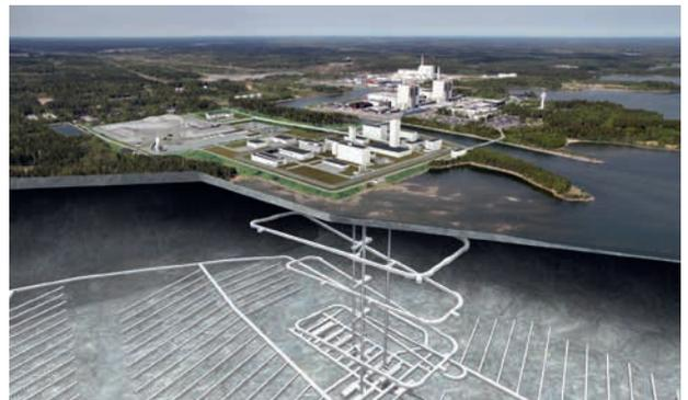
Fotomontage des Tiefenlagers für ausgediente Kernbrennstoffe in Forsmark. Die Gesamtlänge des Tunnelsystems beträgt über 60 Kilometer. Es befindet sich in einer Tiefe von 500 Metern. (Foto: SKB)
