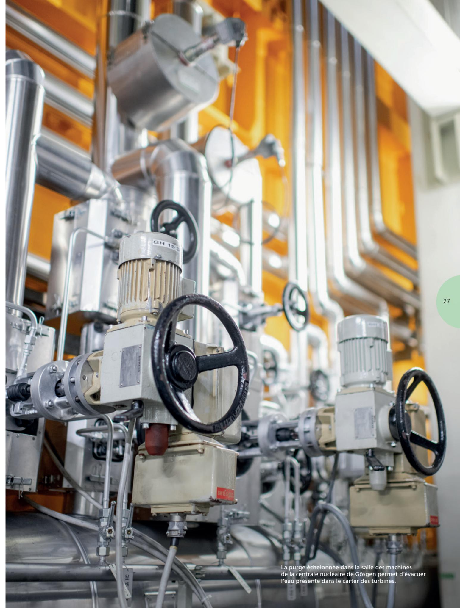
La purge échelonnée dans la salle des machines de la centrale nucléaire de Gösgen permet d'évacuer l'eau présente dans le carter des turbines.
